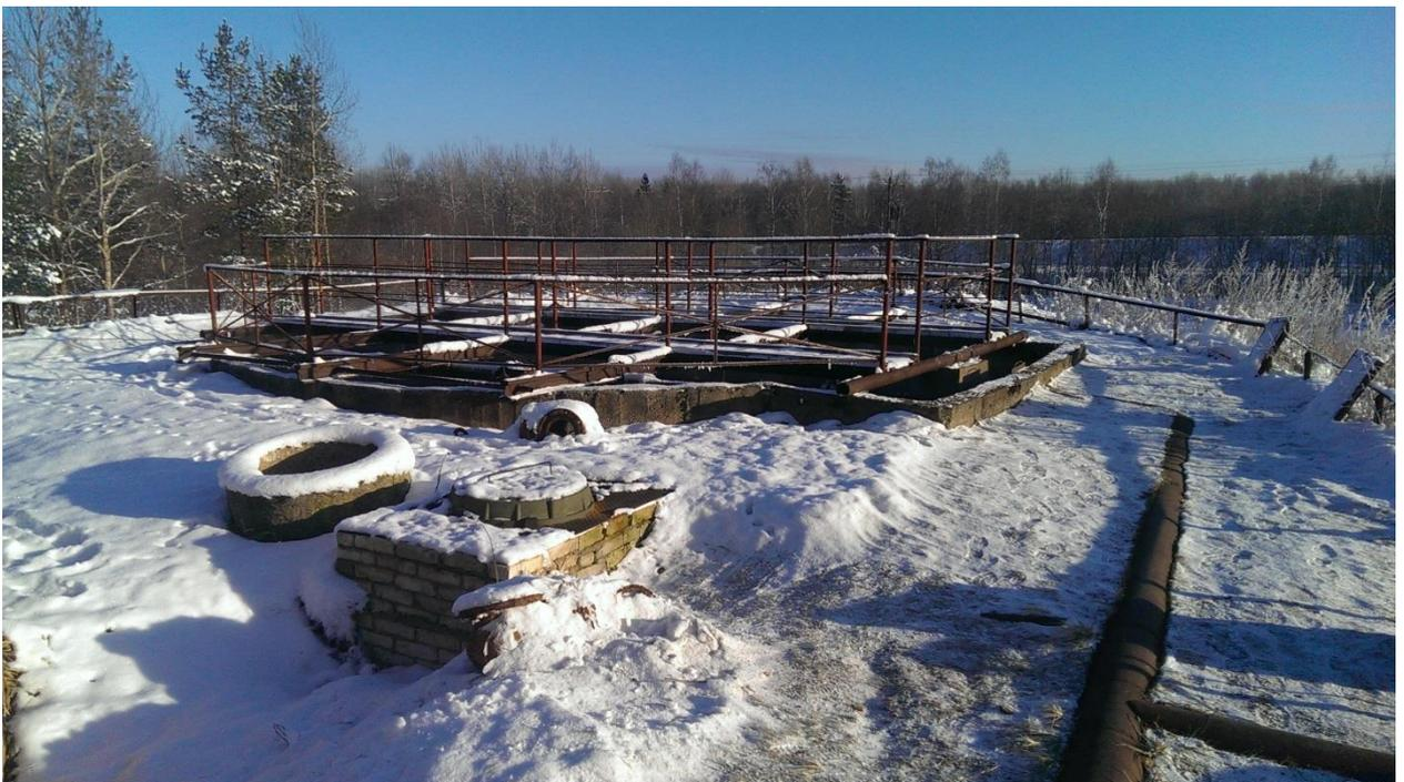
**Рисунок 15 - Сборный трубопровод двухъярусных отстойников**
