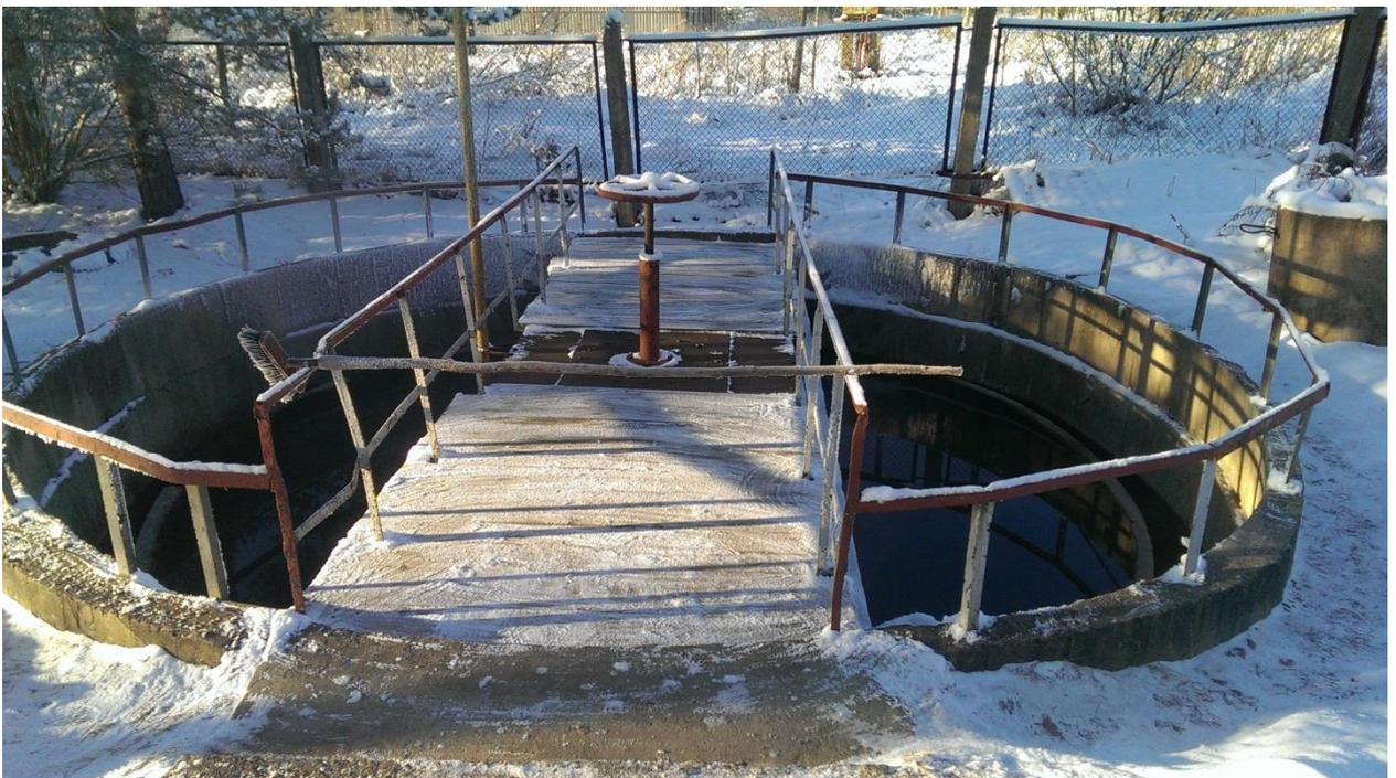
**Рисунок 20 - Вторичный отстойник**
