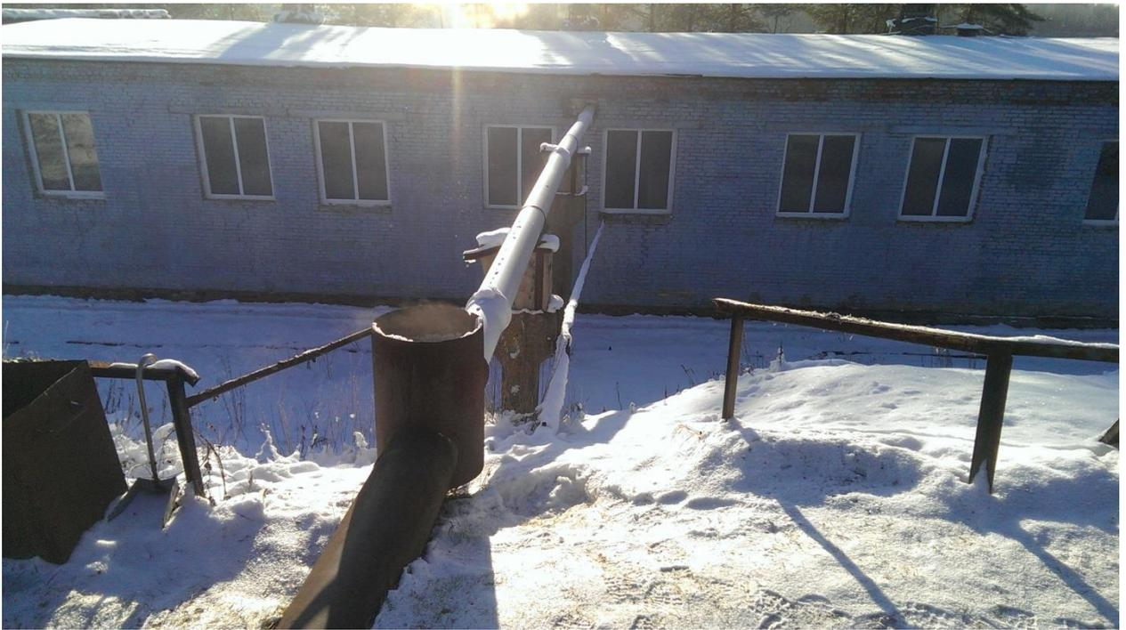
**Рисунок 16 - Транспортирующий участок трубопровода от двухъярусных отстойников**
