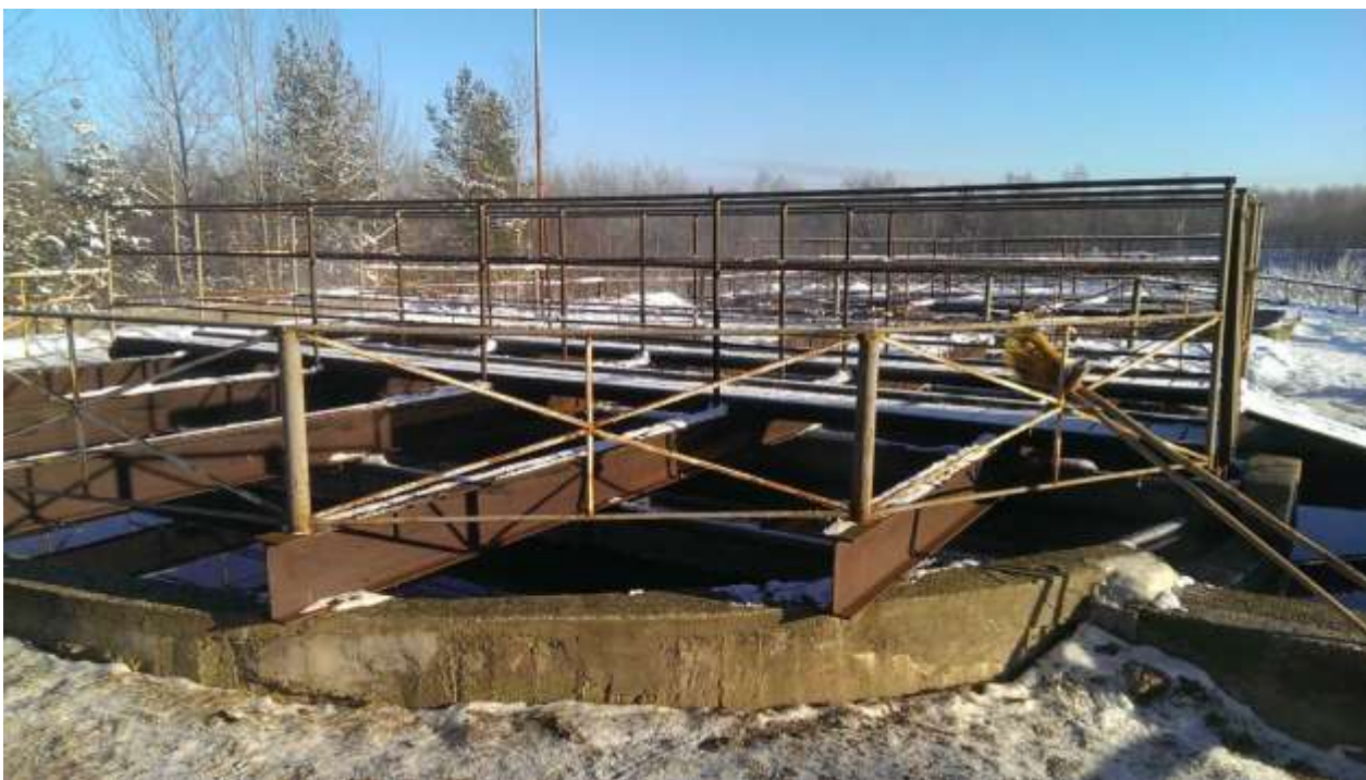
Рисунок 6 - Двухъярусные отстойники
