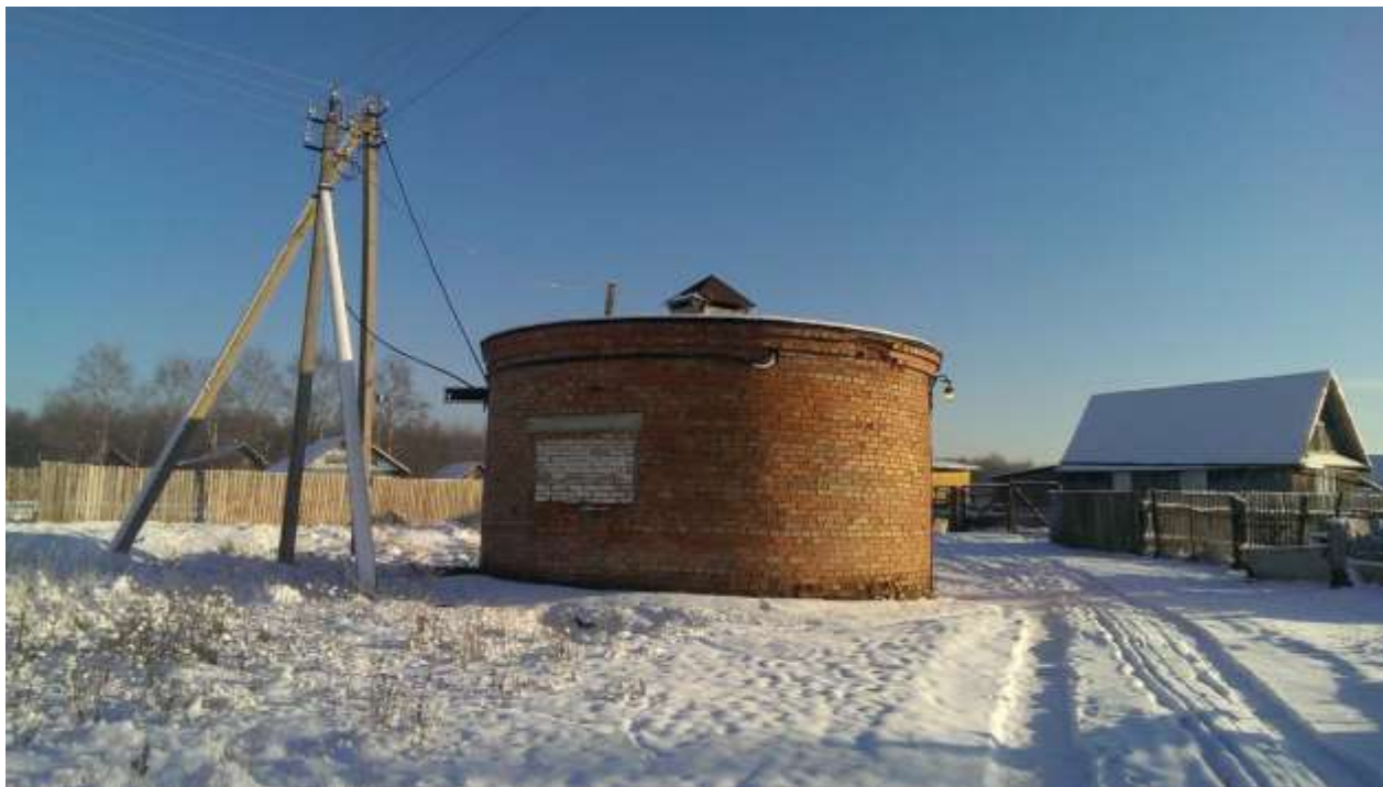
Рисунок 5 - Канализационная насосная станция д. Кусино
