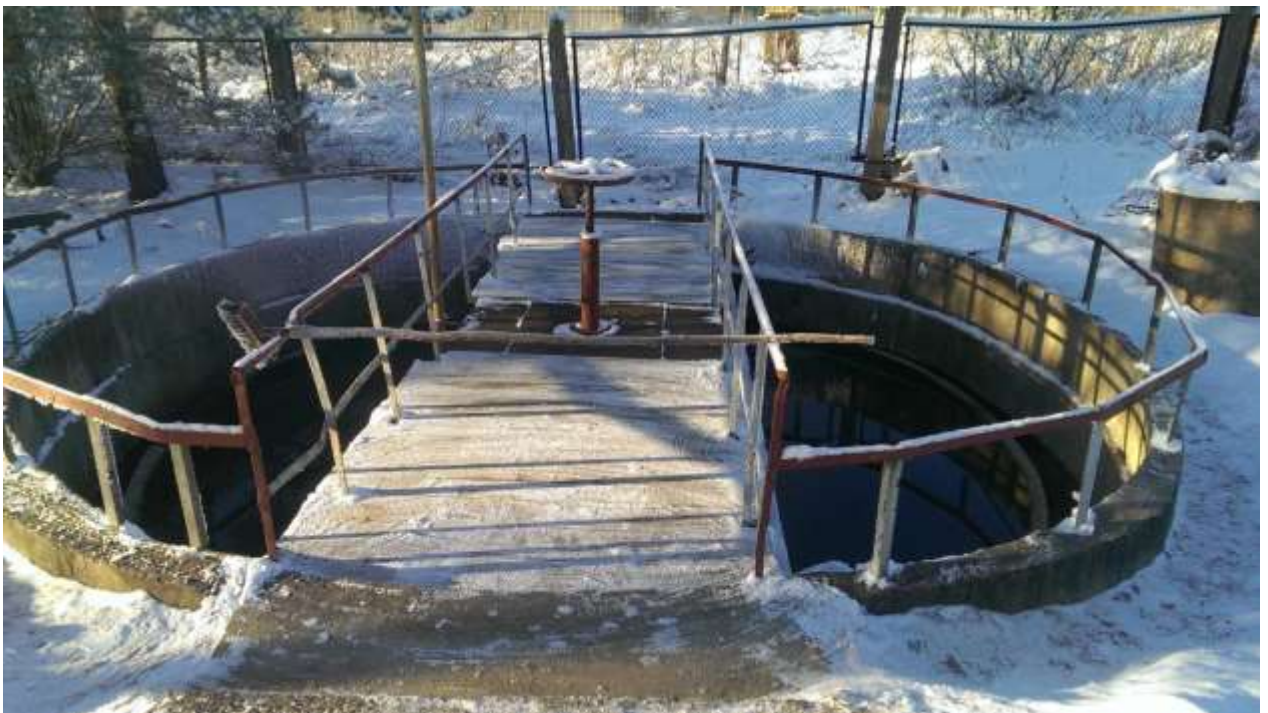
Рисунок 12 - Вторичный отстойник
